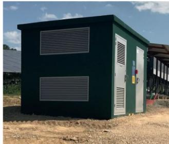
les postes de livraison : installations EDF et protections de découplage assurant la connexion de l'installation avec le réseau public d'électricité ;
